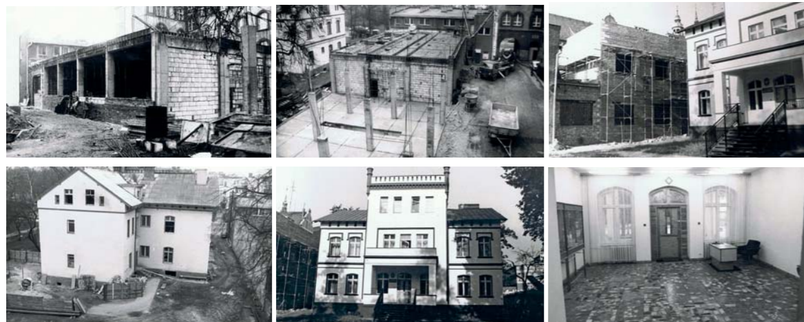
Remont budynku Komendy i jednostki przy ul. Witelona 1988/89 r. Fot. W. Kołodziejski
